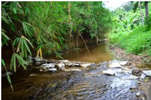
ภาพที่ 3 ฝายชะลอน้ำที่ชำรุด สร้างจาก กระสอบพลาสติกสาน (ถุงปุ๋ย)
